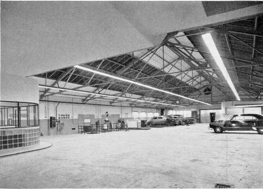
Algemene verlichting in garage met drie enkele rijen buislampen TL-40 W. Verlichtingssterkte gemiddeld 150 lux; lichtstroom 250 lm/m 2 .
