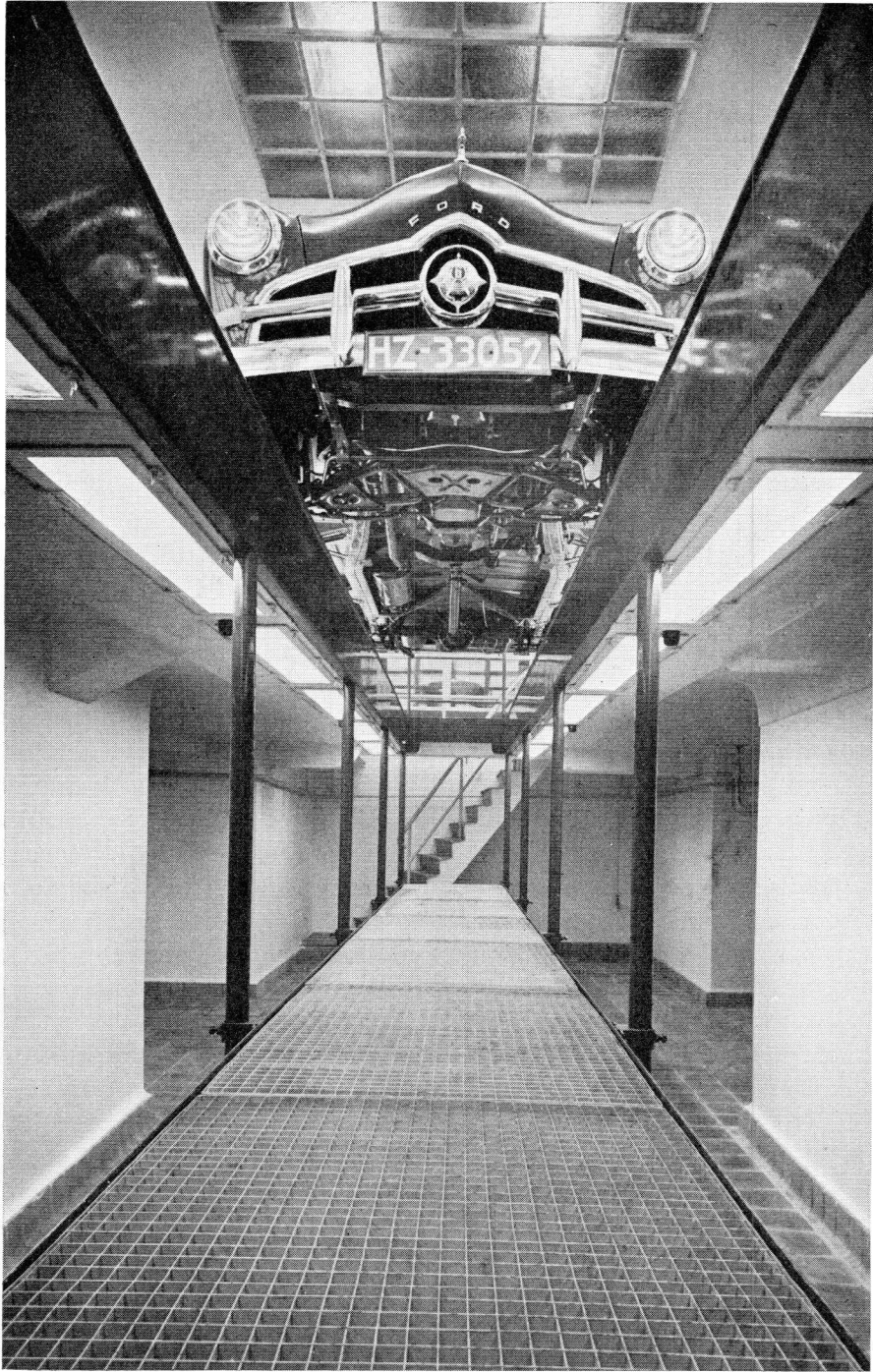
Auto-smeerkuil, verlicht met buislampen TL-40 W. Sterkte ca. 300 lux.
