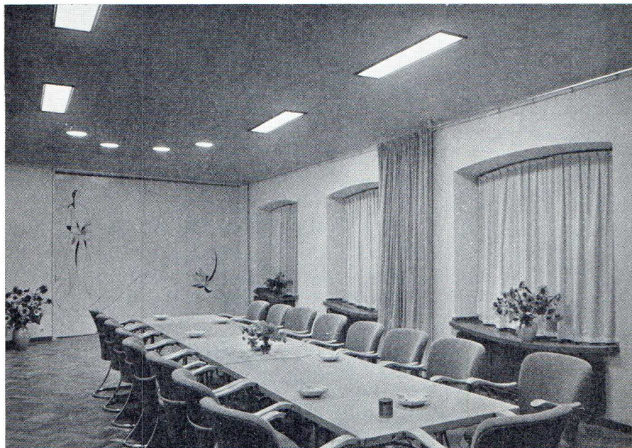
Conferentiekamer. Diffuse algemene verlichting met buislampen TL-40 W in het plafond, afgeschermd met lichtroosters. Aanvullende directe verlichting met reflector-gloeilampen in het plafond.
