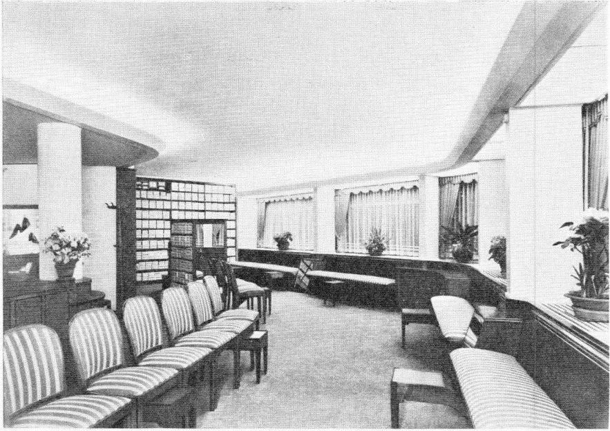
Algemene indirecte verlichting in schoenwinkel door middel van buislampen TL-40 W in koven.
