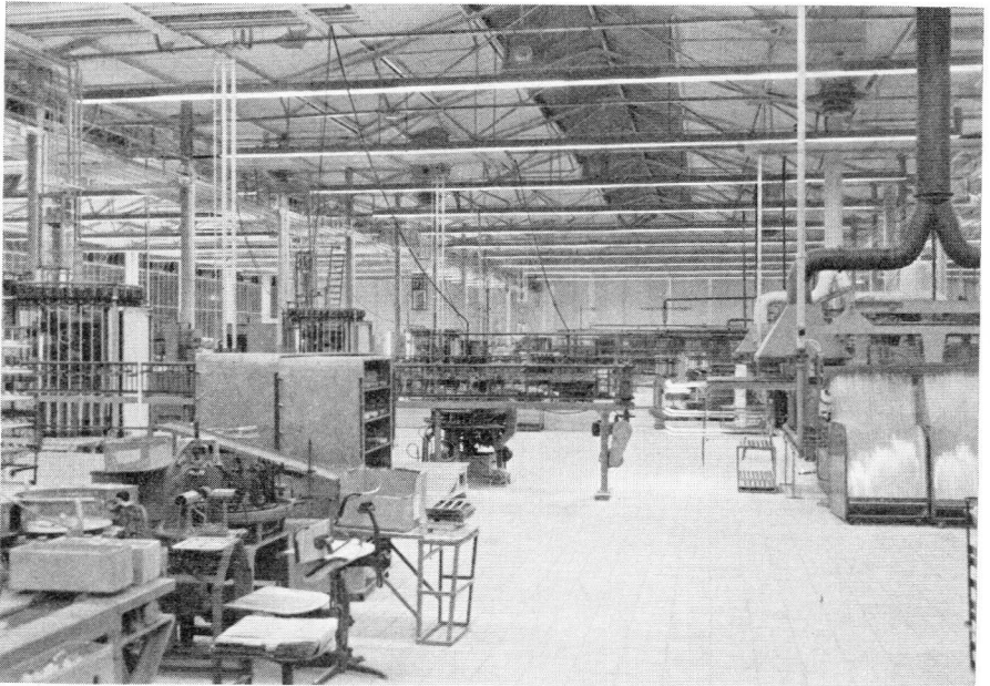
Lampenfabriek, verlicht met dubbele rijen TL-lampen in de reflectoren. Verlichtingssterkte 275 lux; lichtstroom 600 lm/m 2 .
