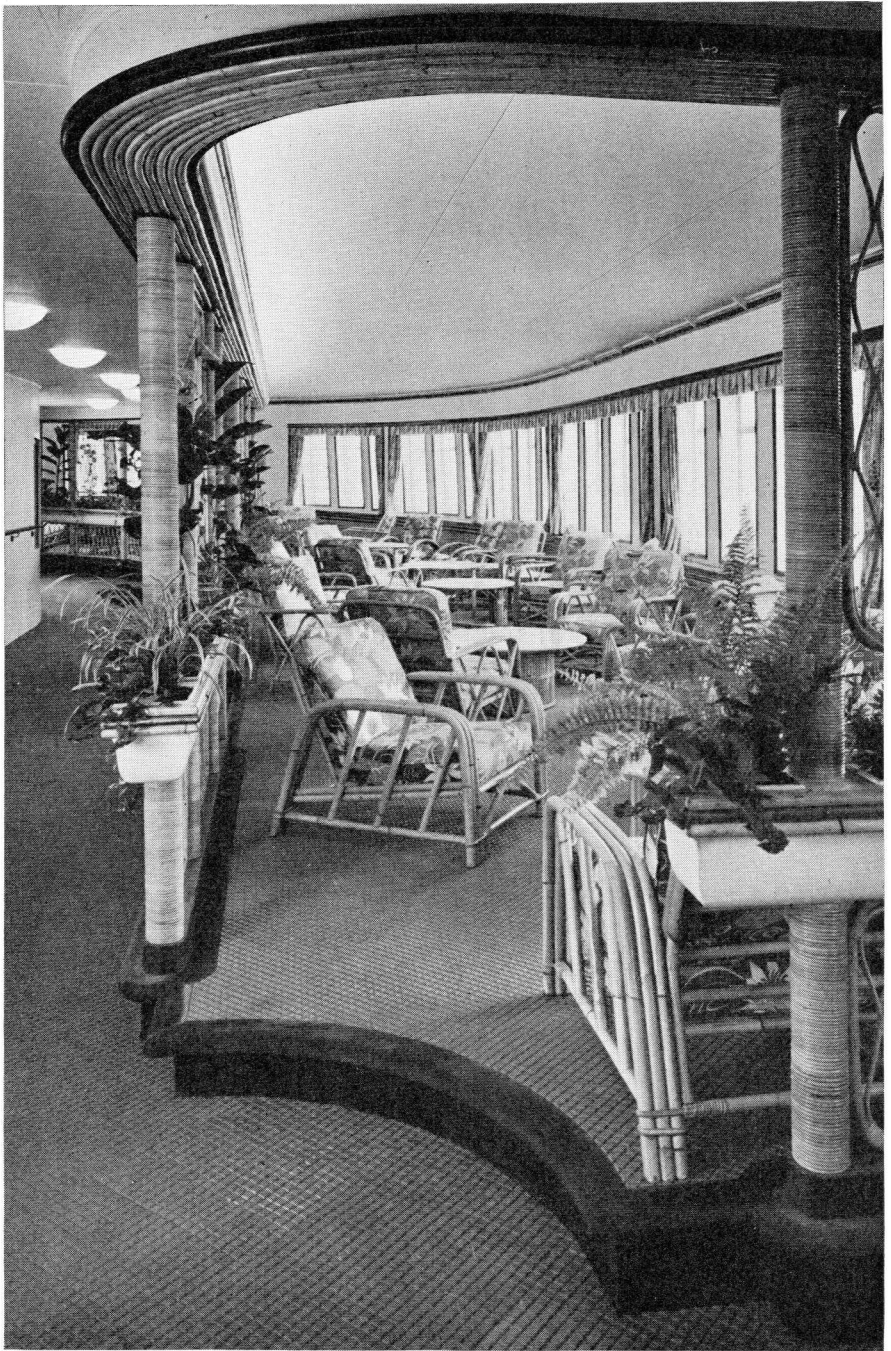
Indirecte verlichting in serre op oceanstomer. Buislampen TL-40 W, wit, in koven.
