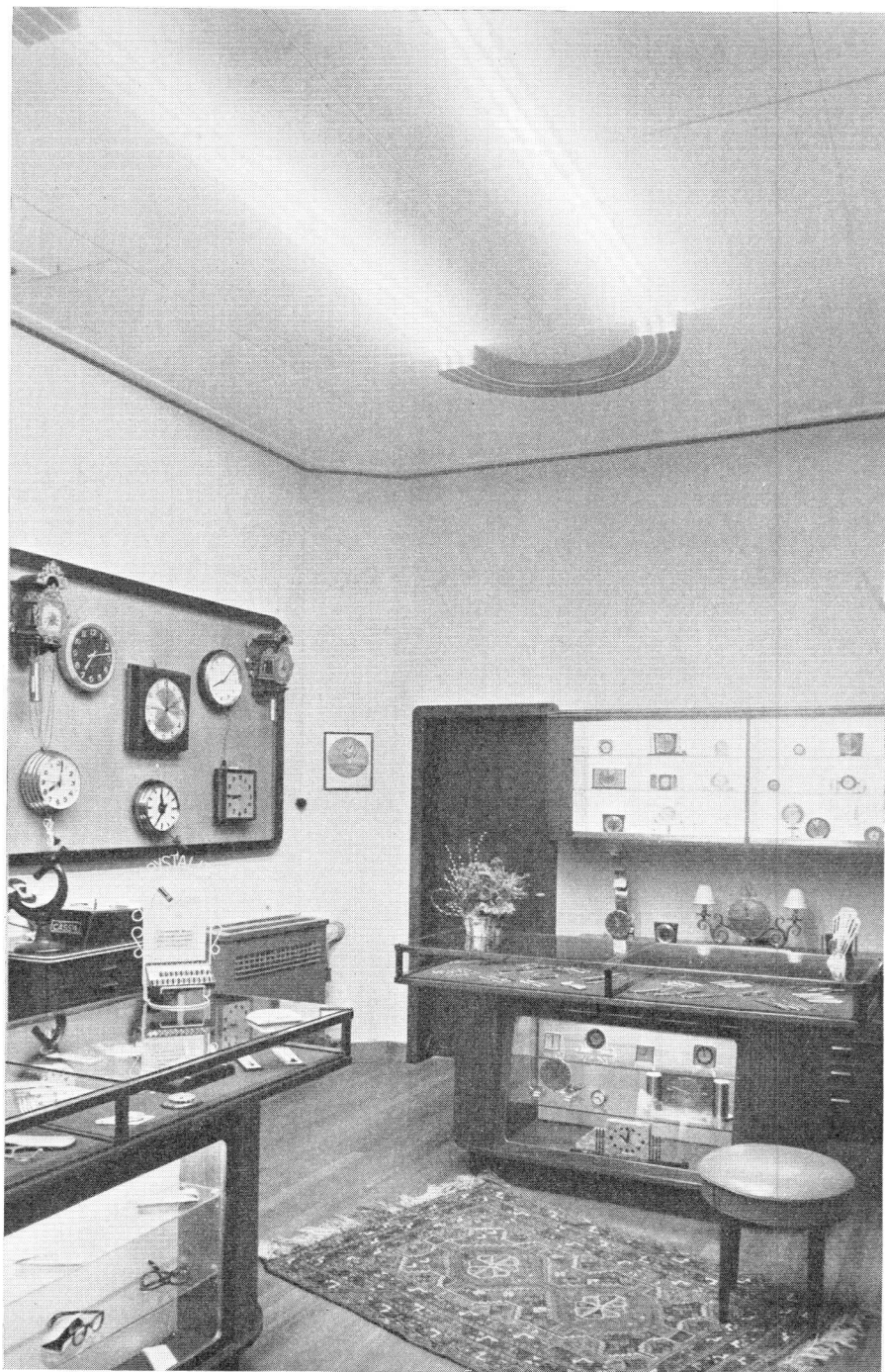
Algemene verlichting met KL-buislampen voor hoogspanning. Verlichtingssterkte 280 lux.
